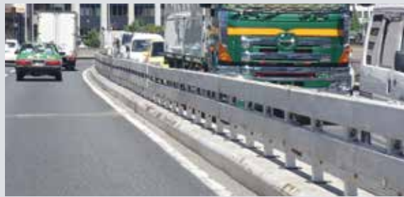
ガードレール(支柱) (溶融亜鉛めっき、ZAM ® 製鋼管)
