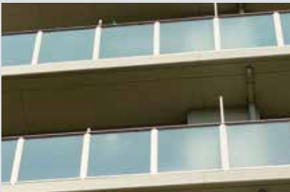
手摺 (酸洗、亜鉛めっき、ZAM ® 製鋼管)
